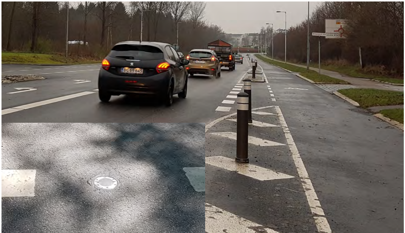
Stort foto: Eksempel på forstærket skillerabat med steler på Frederiksborgvej i Hørsholm Kommune.
