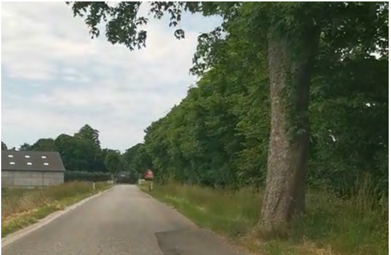
Kantpæle og kantafmærkningsplader kan tydeliggøre vejens forløb og de faste genstande tæt ved vejen.
